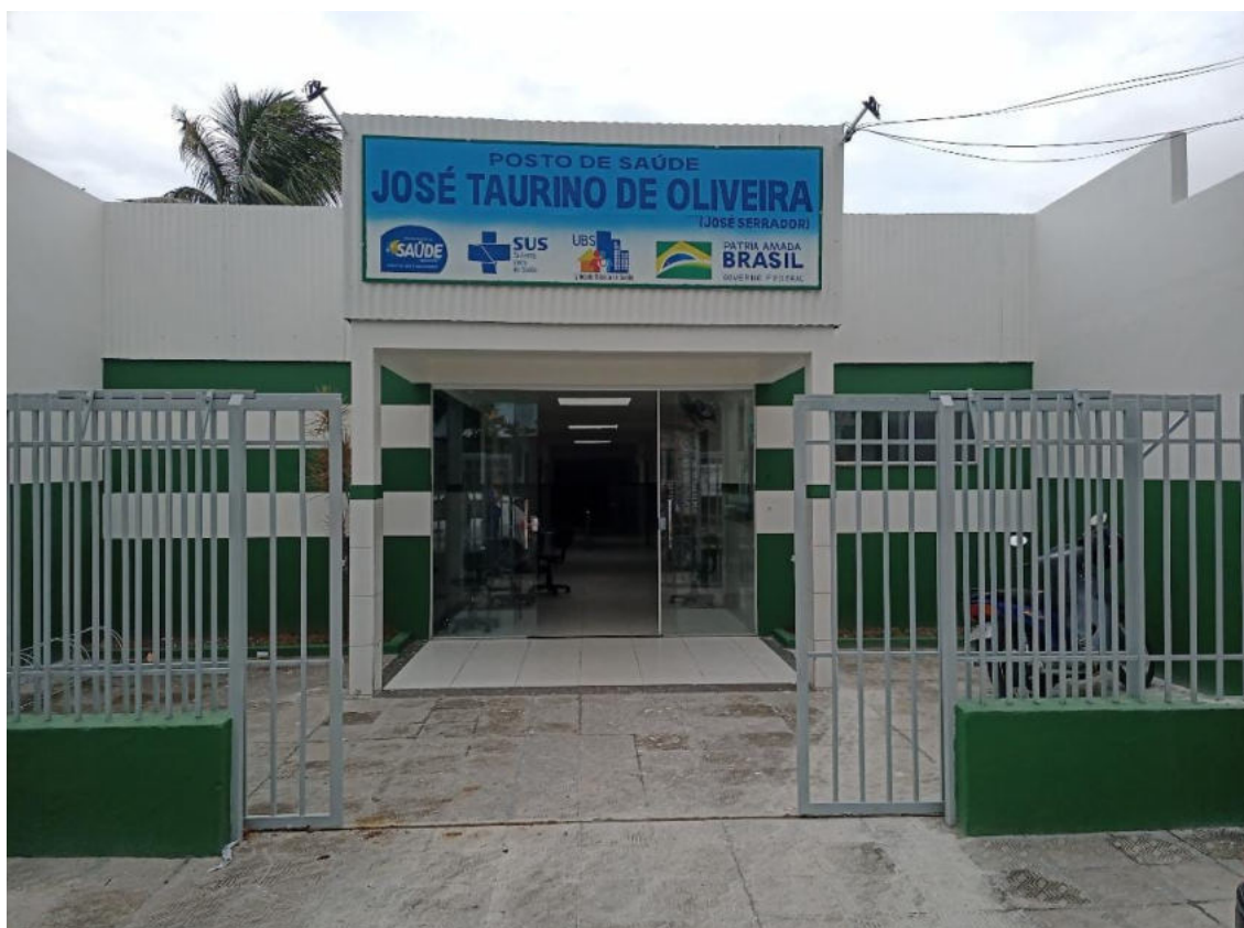
Posto de Saúde do Bairro Biela após a Reforma completa concluída.
