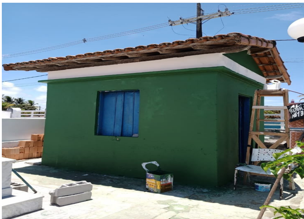
Fachada do Cemitério Municipal Depois da Revitalização
