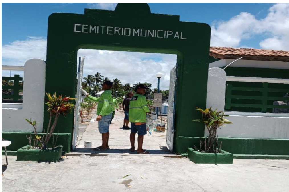
Fachada do Cemitério Municipal Depois da Revitalização
