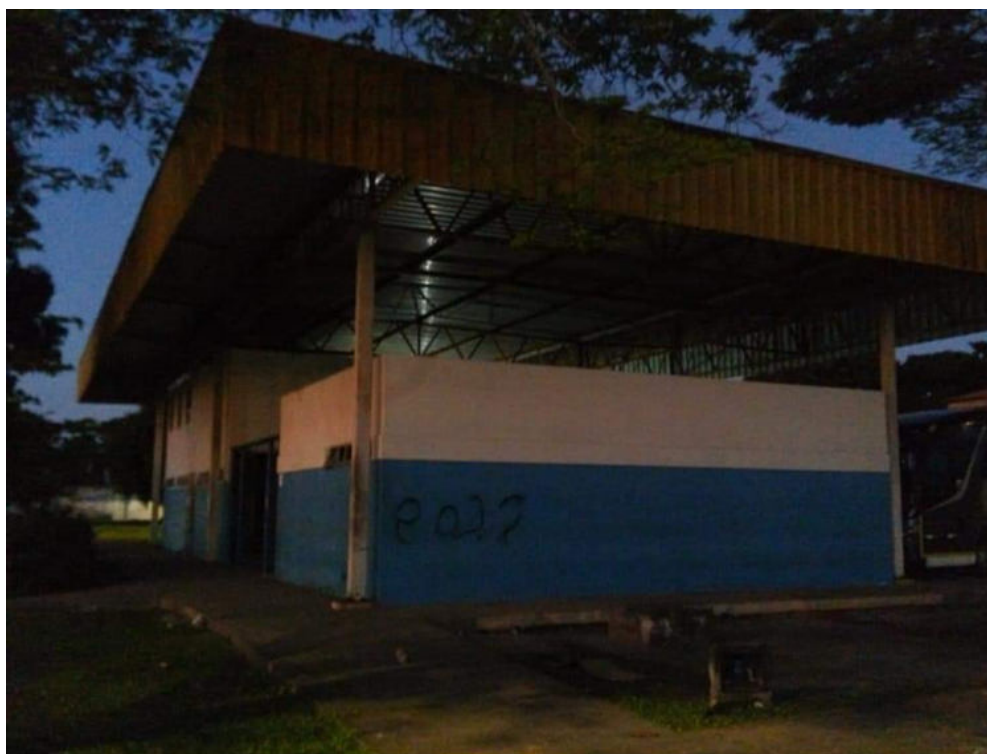
Rodoviária Municipal Antes das Obras de Manutenção
