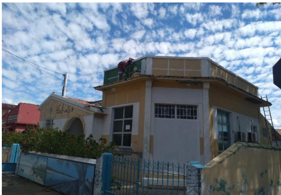
Prédio Municipal da Secretaria de Educação antes das Obras de Reforma e Manutenção do Patrimônio Público.
